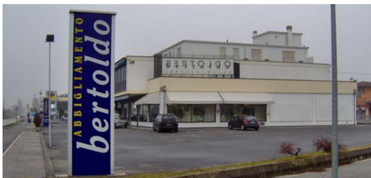
Vista della nuova sede, sopra i Magazzini di Abbigliamento Bertoldo a Legnaro, provenendo da Piove di Sacco (PD)
